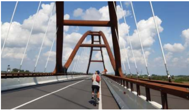
Attraversamento del Po sul nuovo ponte
