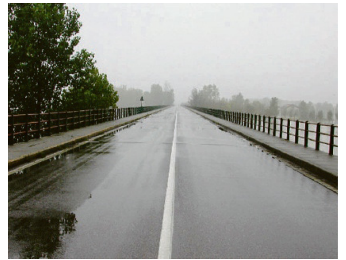
VIADANA. Il ponte che collega Viadana a Boretto (Re)
