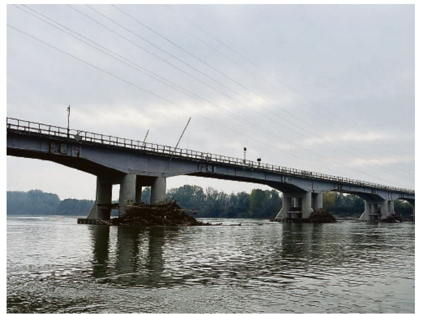
CASALMAGGIORE. Il ponte sul Po che collega Casalmaggiore con Colorno (Pr). Il manufatto è stato chiuso per lavori dal settembre 2017 al settembre 2019
