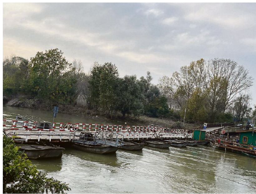
TORRE D'OGLIO. Il ponte sull'Oglio che collega San Matteo con Cesole di Marcaria. Il ponte in barche è soggetto a chiusura in caso di grande innalzamento dell'Oglio
