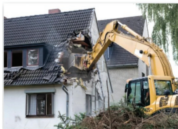
Scavi e demolizioni
