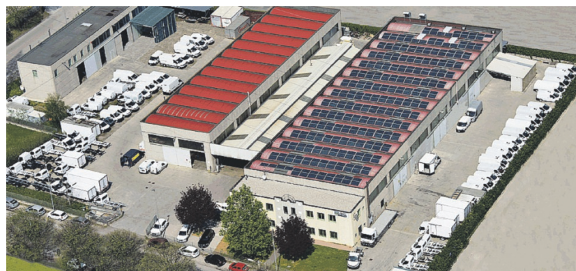
Veduta aerea della sede produttiva di Mantova
